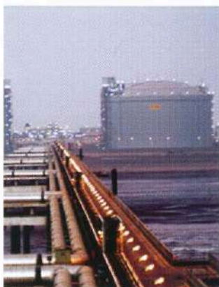
Petronet LNG storage area
